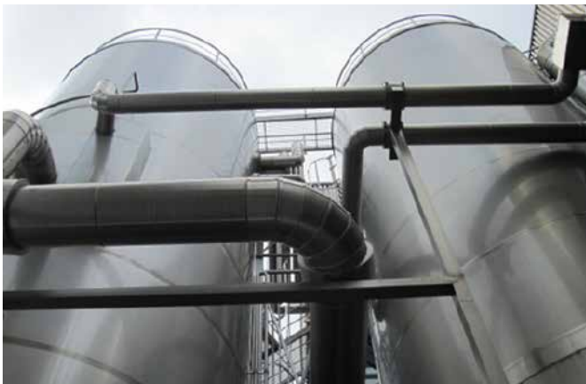
izq.: Silos para capacidad de 5000 kWh cada uno. derecha: Generador para 6 to/h. Con 10 horas de generación de hielo 5.600 kWh.
